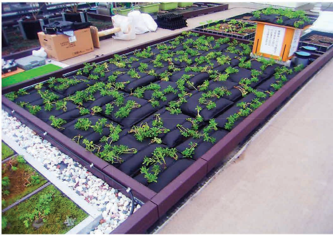
2013/09/26 台東区役所屋上「憩いのガーデン」施工後
